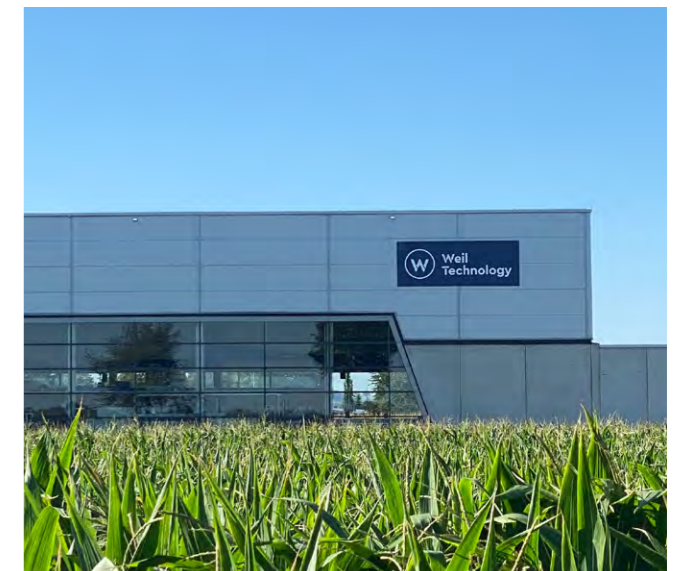
Weil Technology, Müllheim 号工厂
